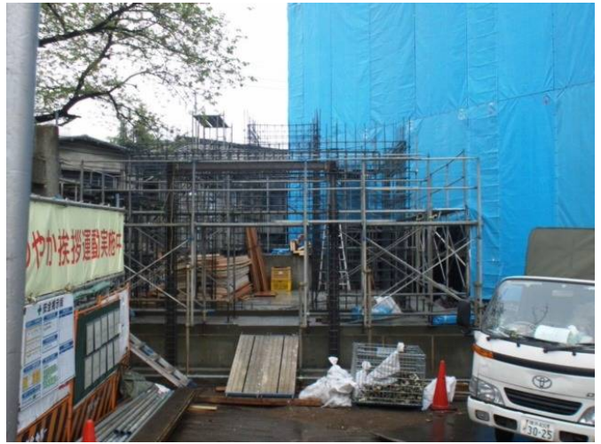
4月19日撮影（鉄骨組み）
