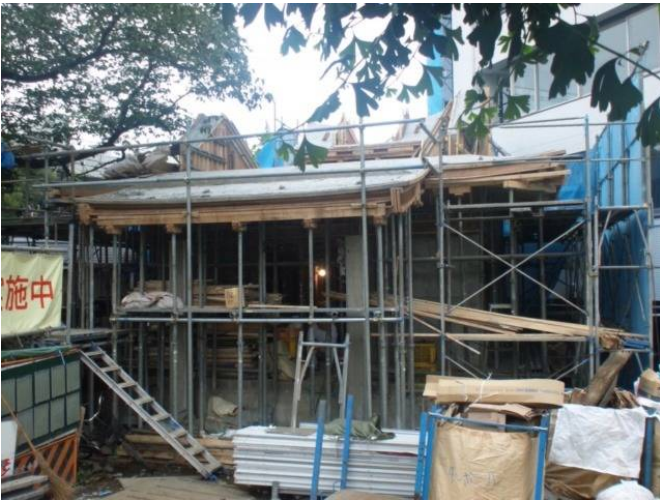
6月14日撮影（コンクリート打ち）
