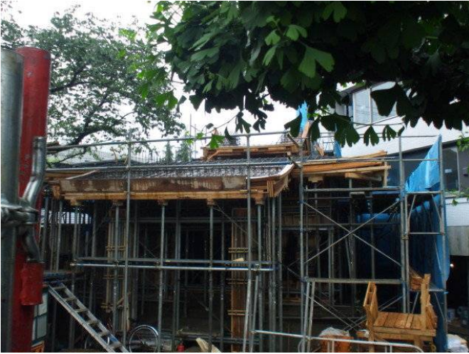
5月29日撮影（型枠組み完了）
