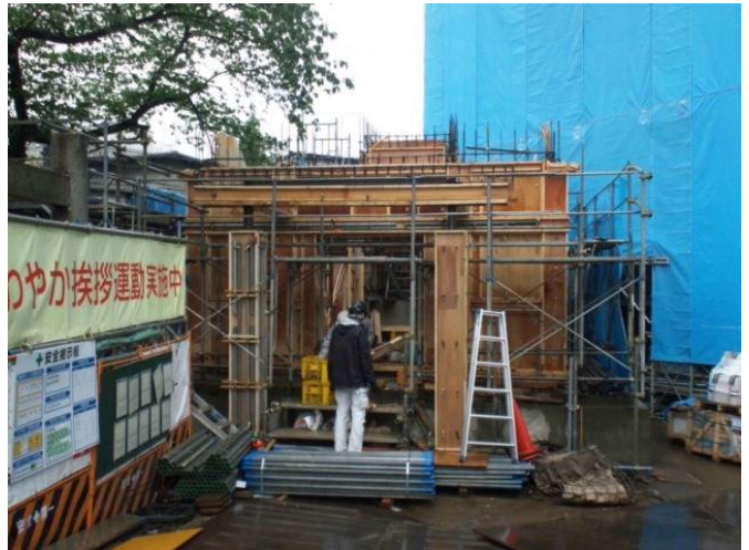
5月11日撮影（型枠組み）
